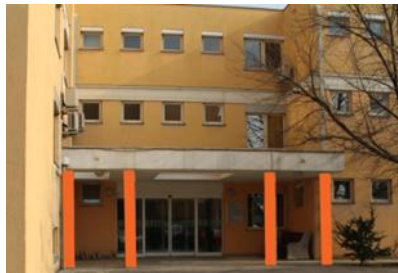
Slika 8: Razviden vhod v stavbo.
