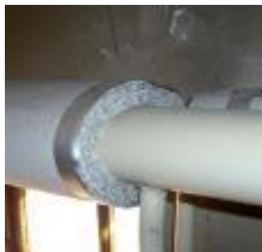
Azbestno platno za izolacijo cevovoda
