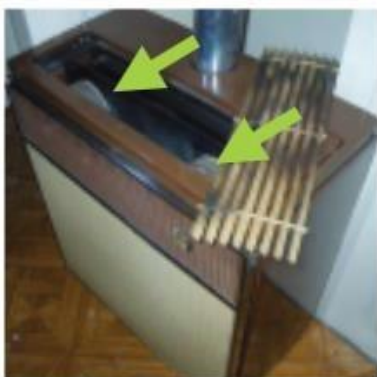
Termoakumulacijski grelniki
