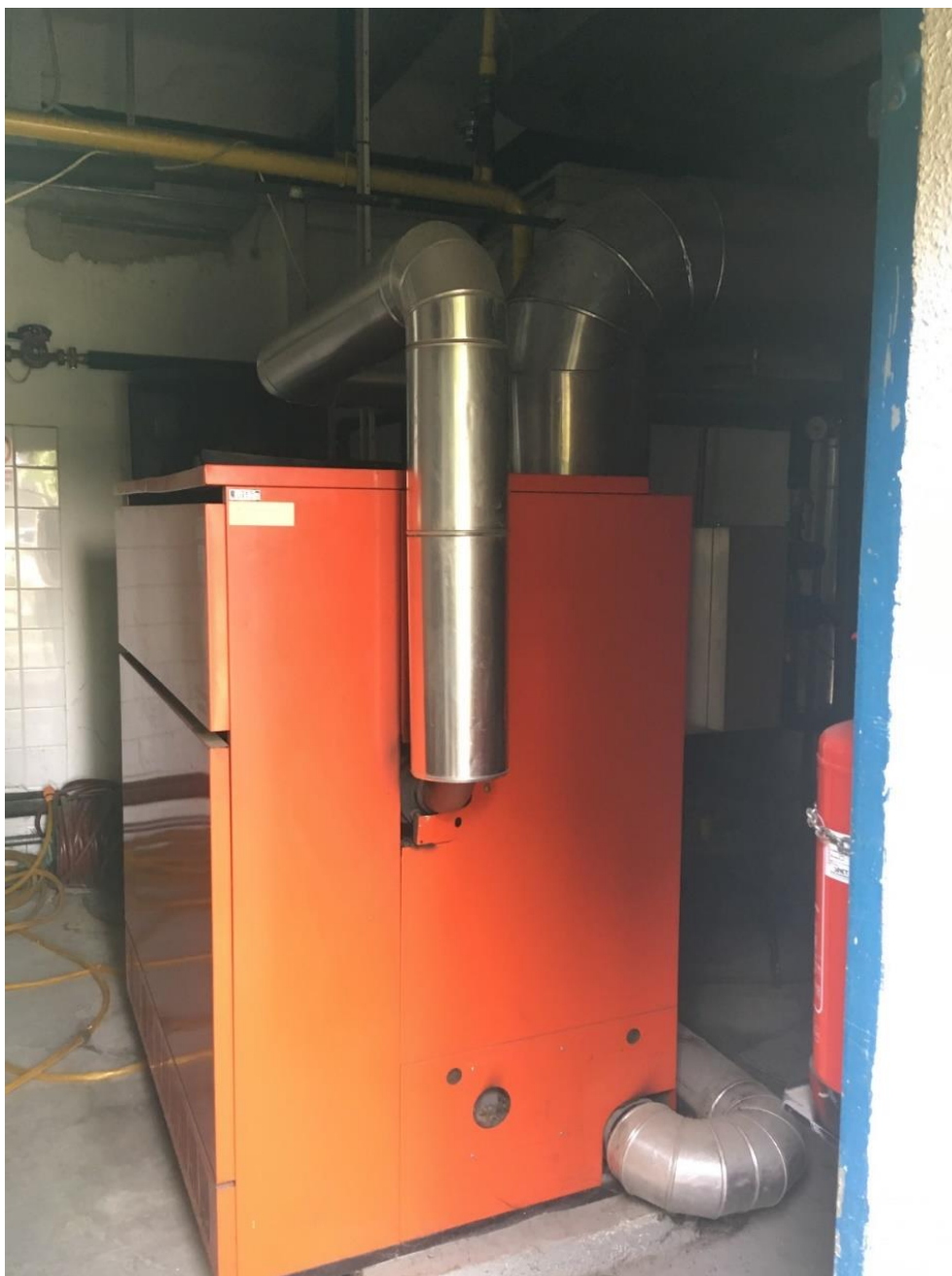
Slika 4.1: Atmosferski kotel na zemeljski plin
