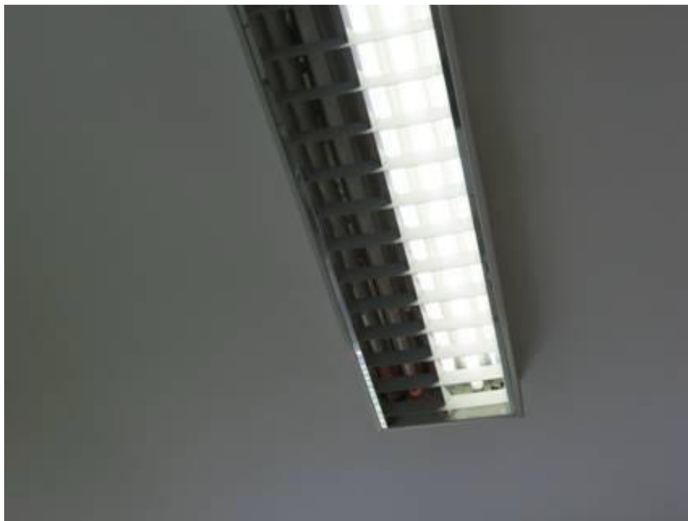
Slika 4.7: Primer vgrajene luči s T8 sijalko
