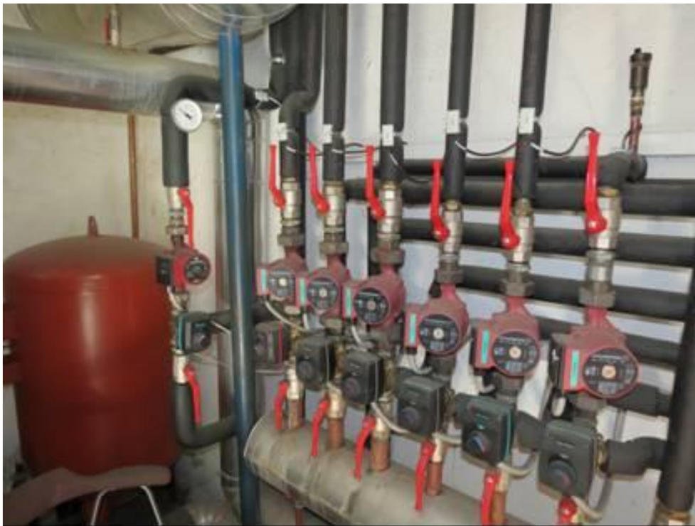
Slika 4.3: Črpalke brez frekvenčne regulacije, raztezna posoda
