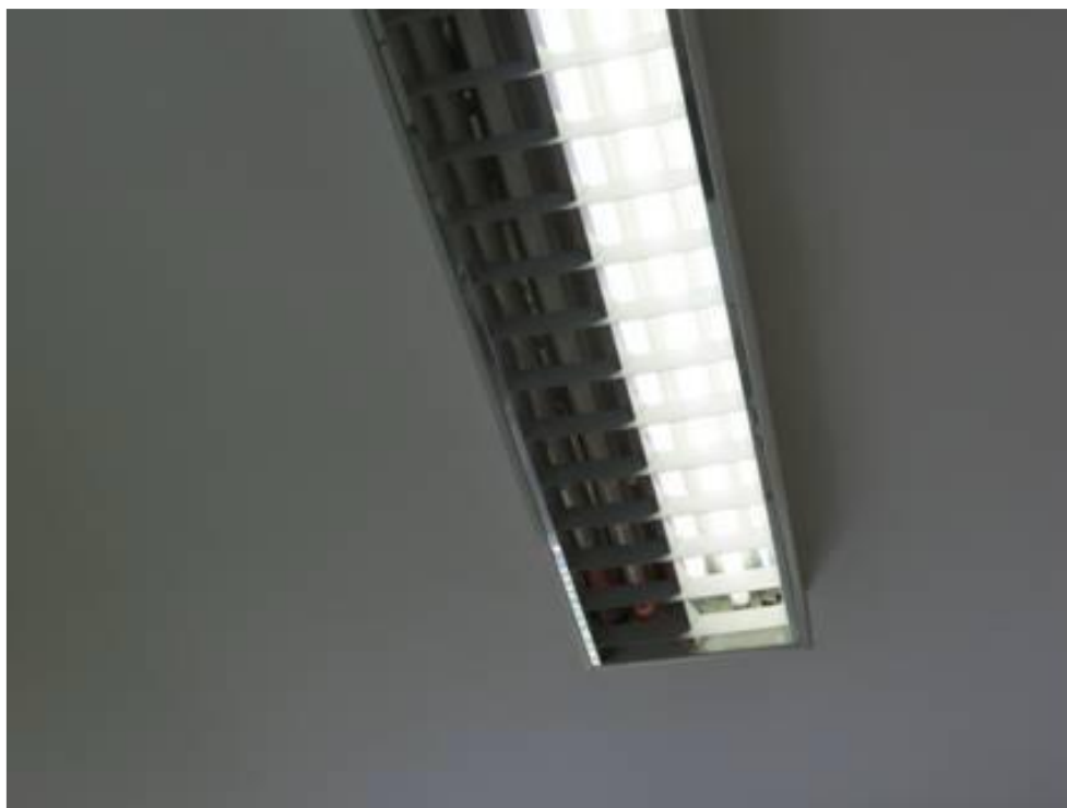
Slika 5.4: Primer vgrajene luči s T8 sijalko
