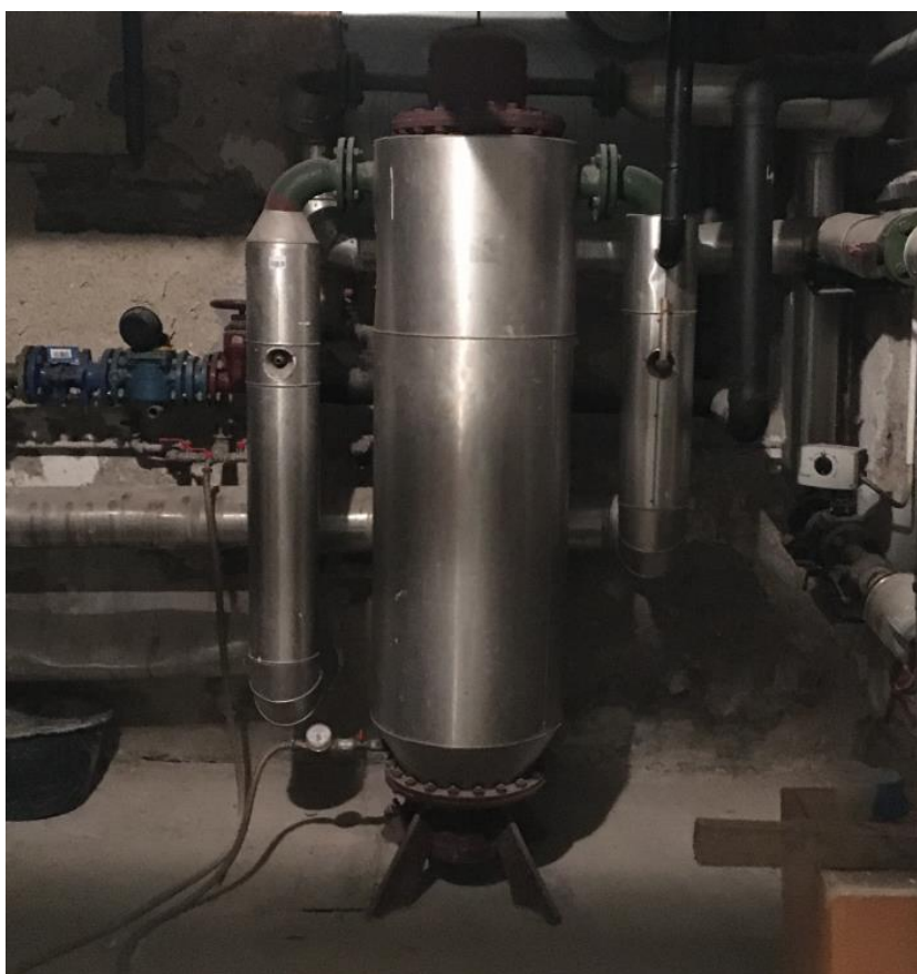
Slika 4.1: Zastarel spiralni toplotni izmenjevalec
