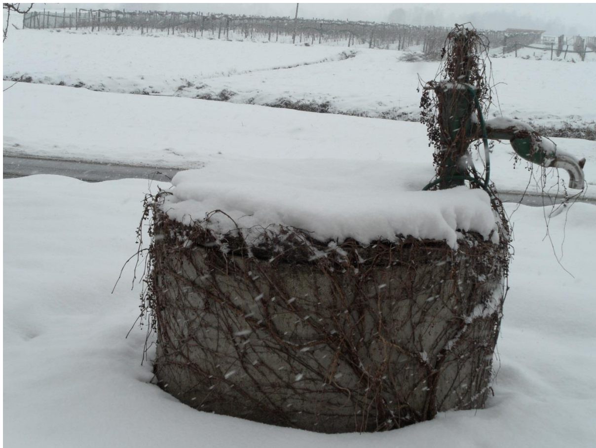
Slika 5: Izkopani vodnjak z ročnim črpanjem
