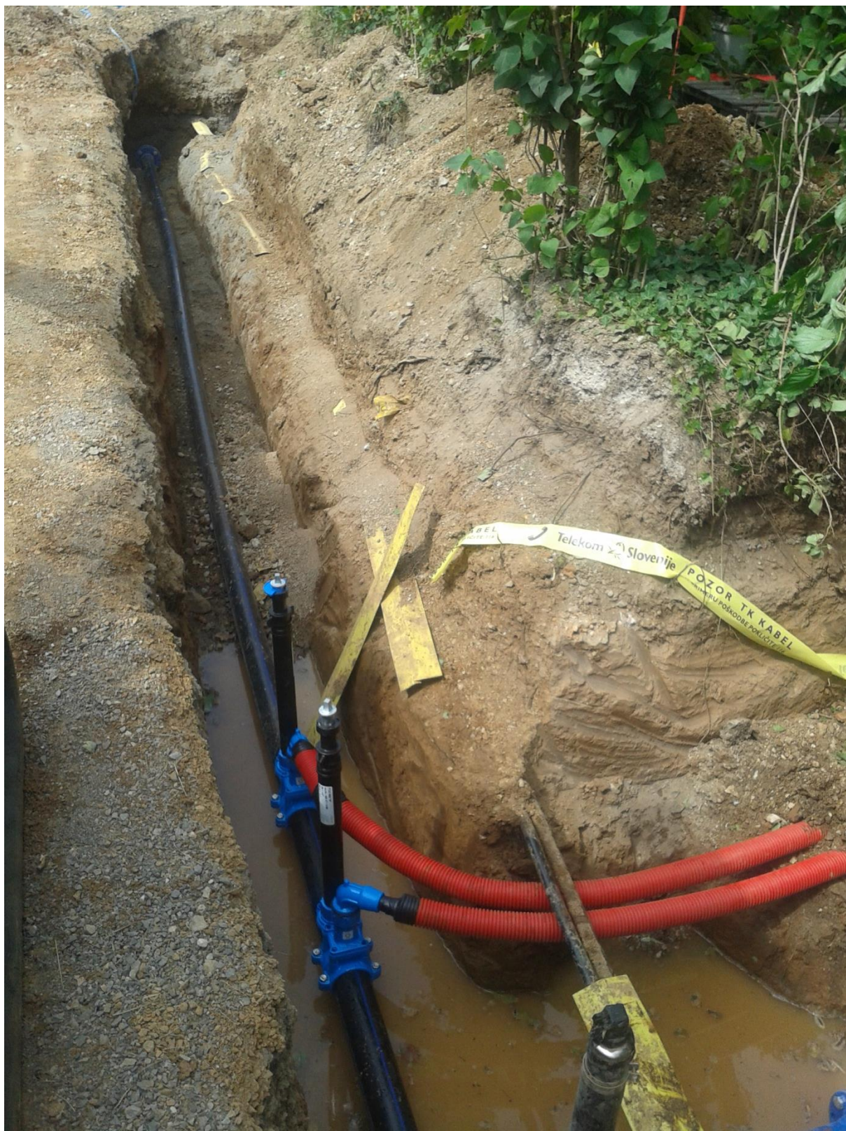
Slika 10: Slika vgrajenega vodovodnega omrežja Vir: Arhiv NLZOH
