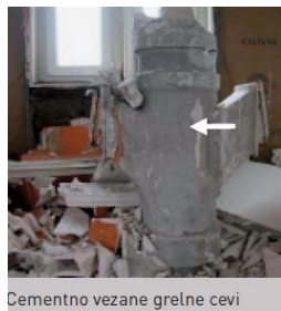
Cementno vezane grelne cevi
