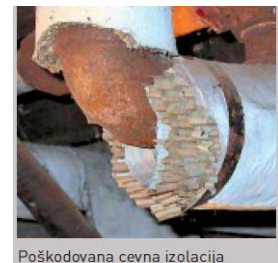
Poškodovana cevna izolacija
