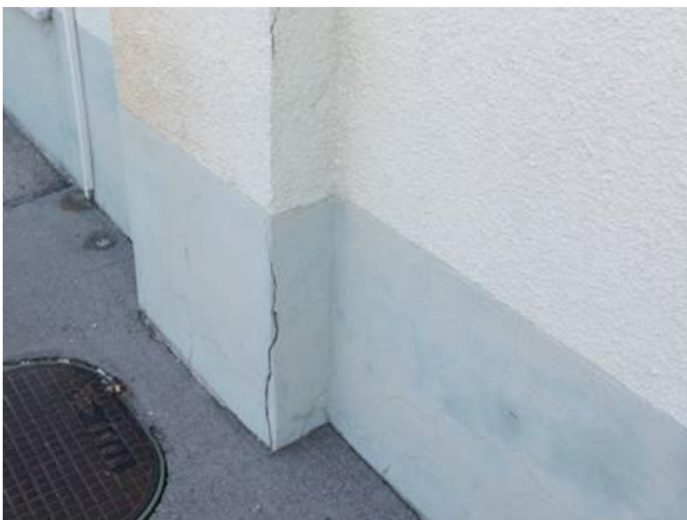
Slika 5.1. Zunanja fasada brez toplotne izolacije
